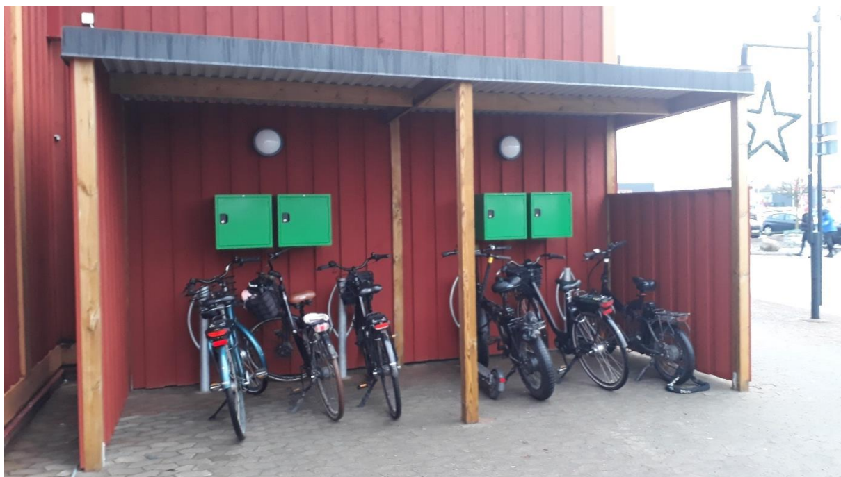
Figur 6 Exempel på cykelparkering. De gröna skåpen är låsbara och har eluttag, vilket gör att cyklister kan ladda sina cykelbatterier säkert där. I samma skåp kan cykelhjälmen låsas in. Exemplet är från ICA Maxi Flygstaden i Halmstad. Fotodatum 2022-01-01. Notera att placeringen av pollare är felaktig, de ska placeras en meter ut från väggen för att det ska vara enkelt att låsa fast cykelns ram.
